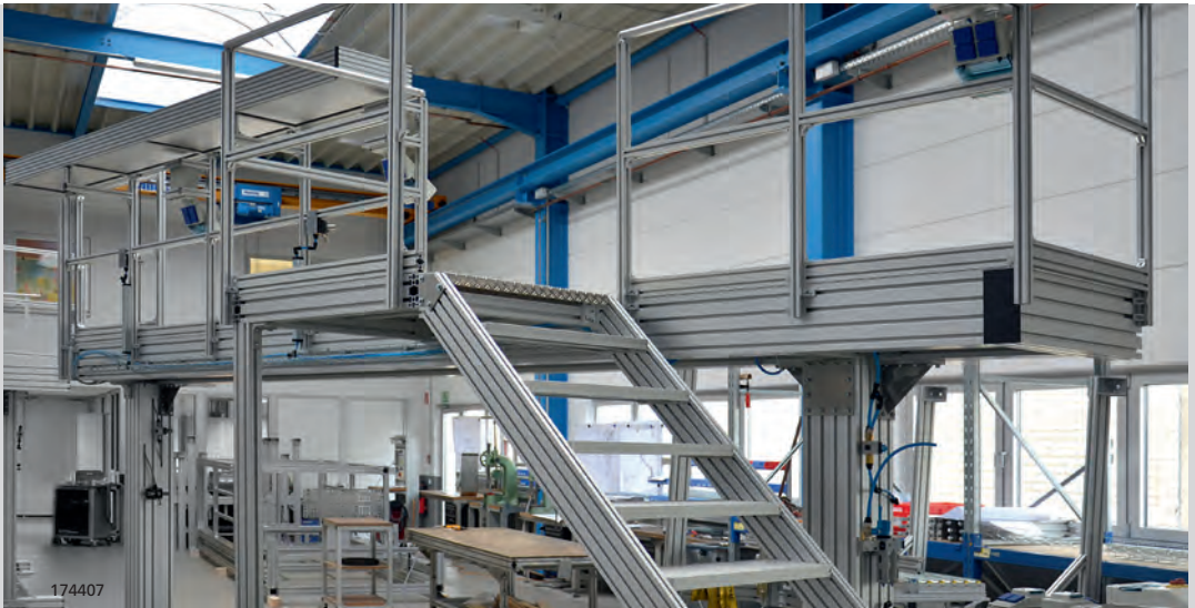
Freitragende Montagebühne mit 45° Treppe
