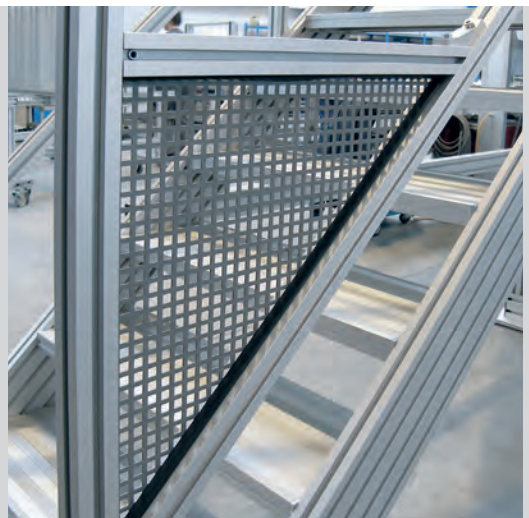
Füllung aus VA Lochblech 10x10 mm
