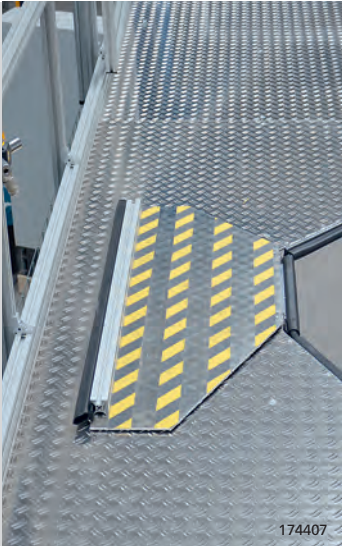
Montageklappe im Podestboden mit Antirutschbelag auf der Unterseite
